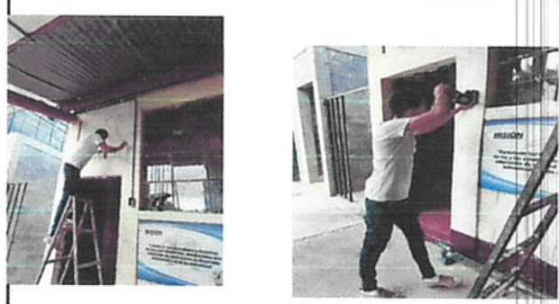
Foto 4: Cambio Cableado Electrico de todo el Establecimiento
